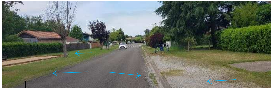
Espace 10m Bordures + caniveau large voie 6m Trottoir 4m environ Bordures + caniveau
